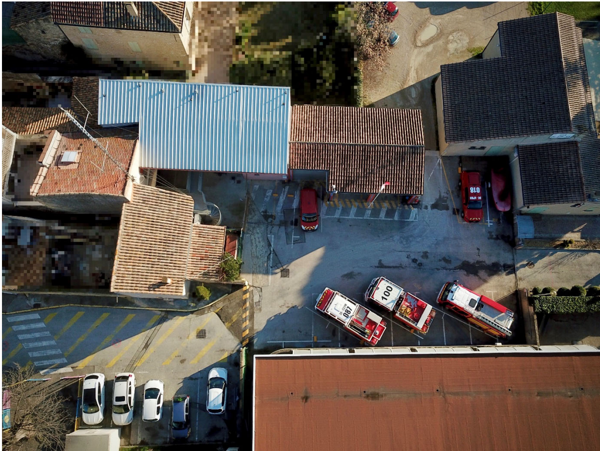
Vue aérienne centre de secours actuel de Roquemaure
