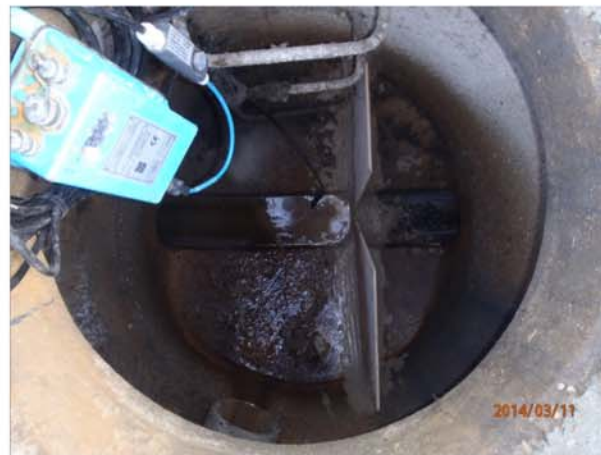
Mise en place de matériel de mesure de débit dans les réseaux
